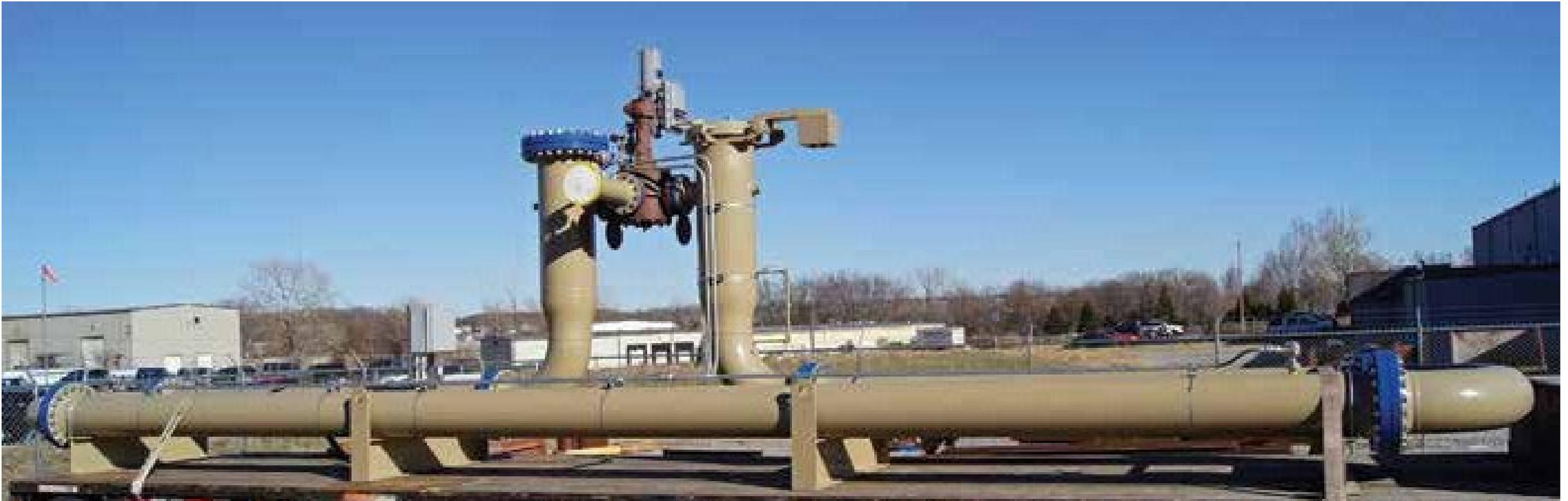
**Probador Bidireccional de Sección Calibrada Recta**
